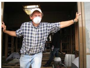
に除去し、壁板をも剥がして、汚水が染みこんだ断熱材も撤去した。上部の柱や鴨居などはその塵をも払い、パワーウォッシャーで洗浄消毒してから乾燥させた。それから新しい断熱材を入れ直しタイガーボードを張った。直ぐに大工が内装に取りかけられる状態までの支援である。それは徹底的に相手の立場に立つての手を抜かない作業であった。
